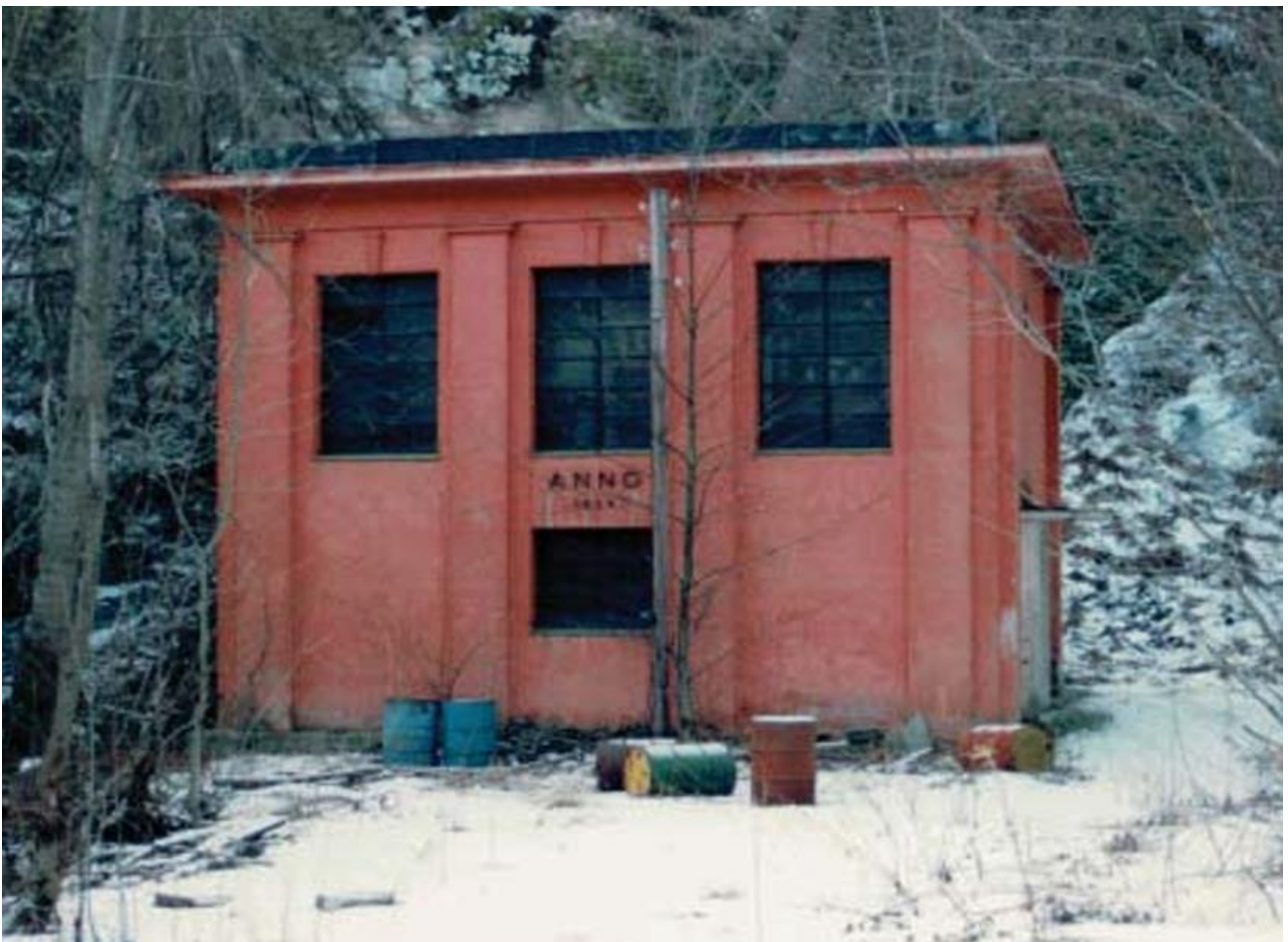
Kraftstasjonen lå der hvor Møllebruket lå før Berger Fabrikk ble bygget. Det står ANNO 1887 på bygningen som ble jevnet med jorden av et jordras i 2000. Foto: Hans Martin Øien
